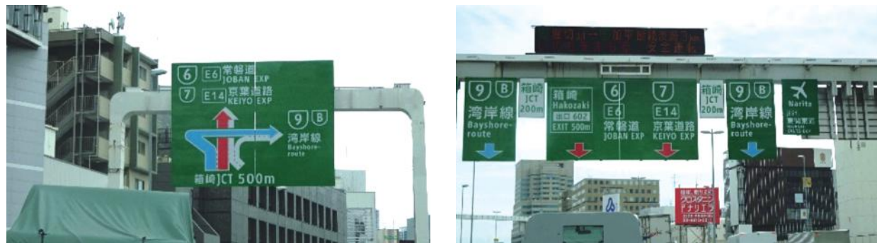
首都高速道路での色分け事例(箱崎ジャンクション)
